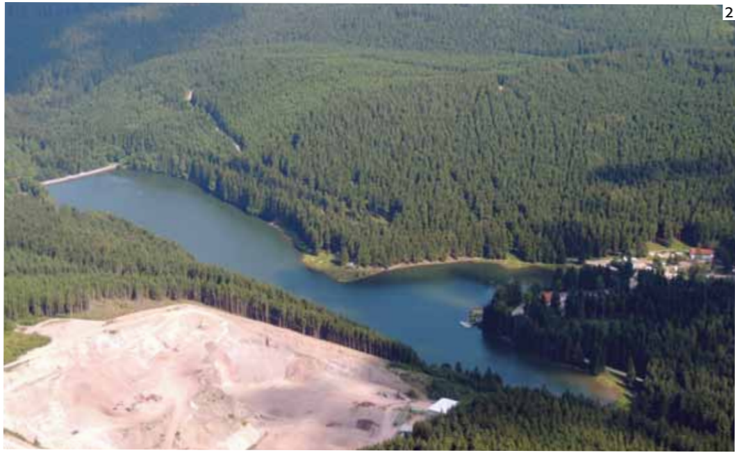
Im Luftbild wird die Nähe des Steinbruchs zum Stausee deutlich
