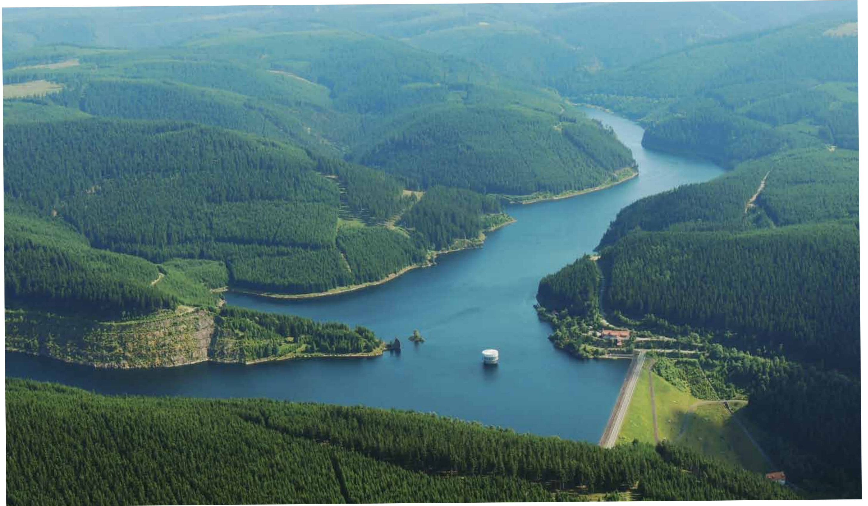
Schmalwasser-Talsperre bei Tambach-Dietharz
