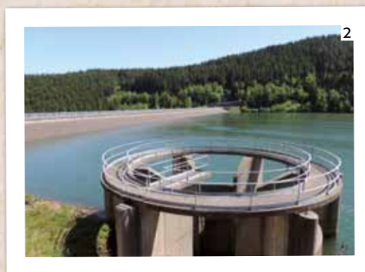
Schachteinlauf der Hochwasserentlastung, ein Stollen führt in das Tosbecken
